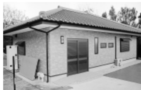
▲完成した来川コミュニティセンター
